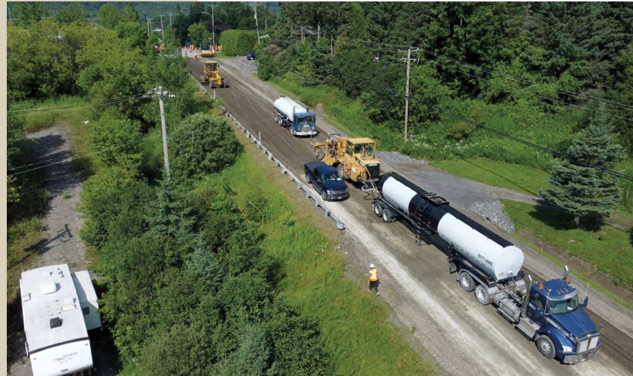
Retraitement en place avec stabilisation. La technique est réalisée à froid sur une profondeur allant jusqu'à 200 mm. Travaux réalisés sur le chemin du Lac-Écho à Prévost, en août 2022.
