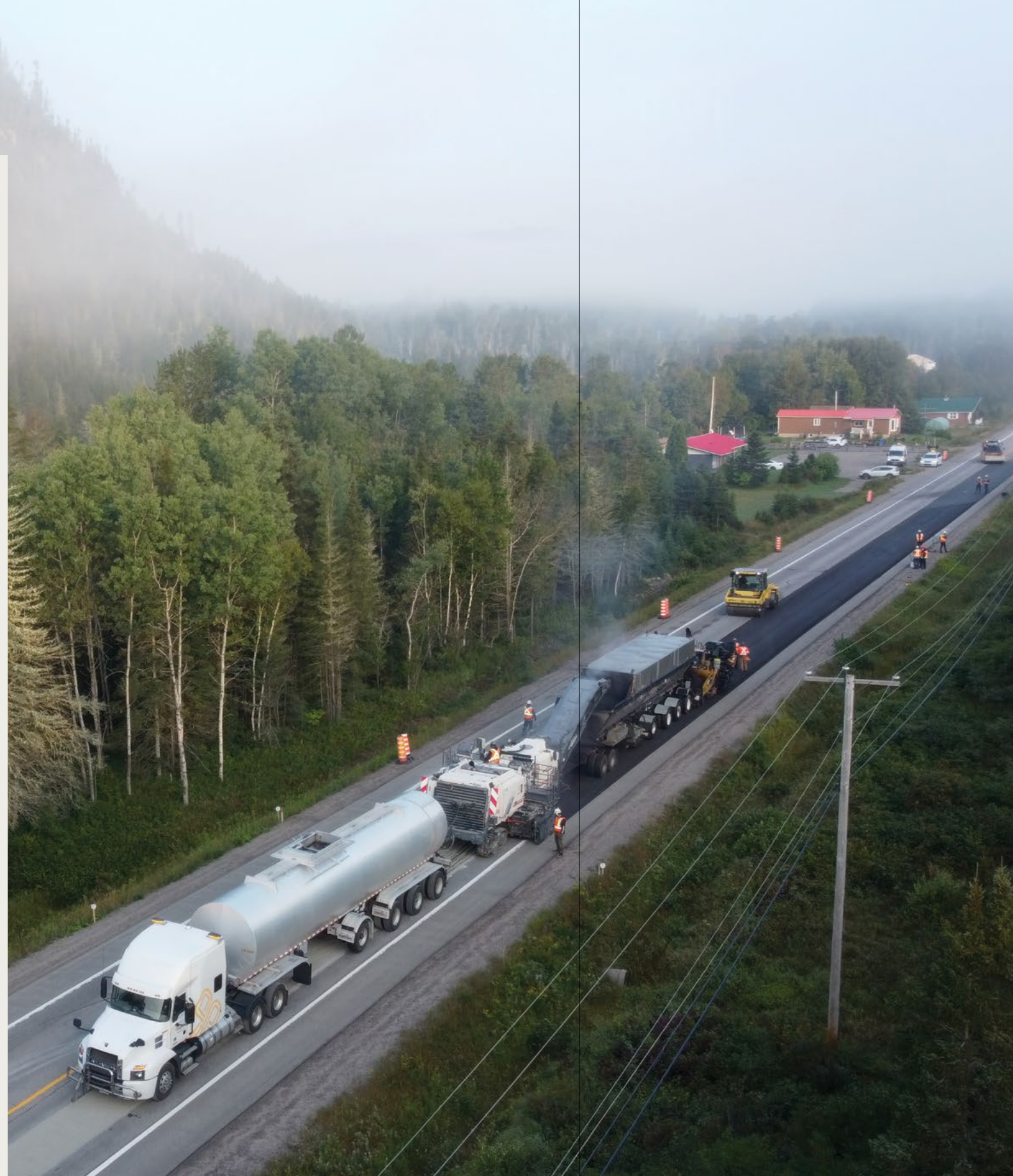
Chantier utilisant la technique de recyclage à froid à Rivière-Éternité, au Saguenay, réalisé en juillet 2024.
