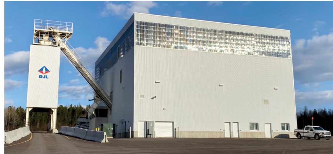
Usine d'enrobés installée sous bâtiment à New Richmond, donnant lieu à une intégration harmonieuse dans le cadre de vie des riverains et un contrôle des émissions de poussières et des nuisances sonores ainsi qu'à une diminution des besoins énergétiques.
