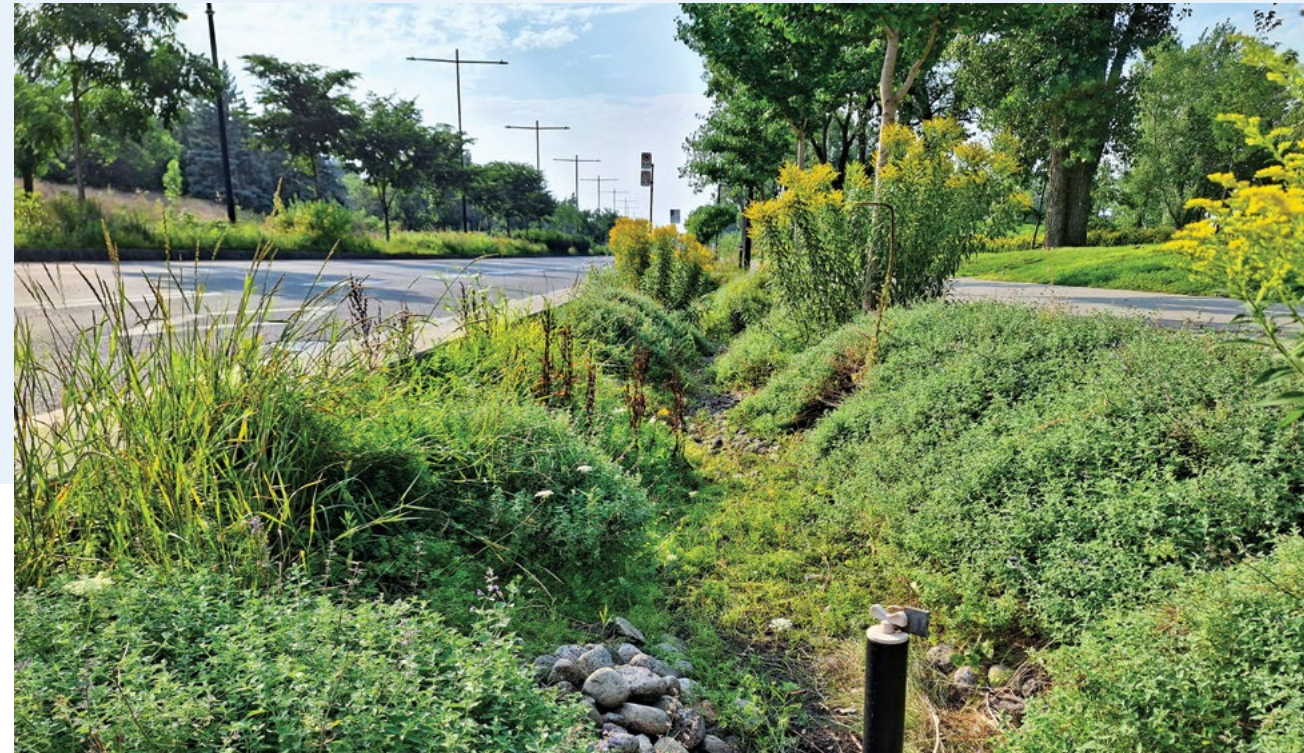
Réalisé en 2016-2017, le réaménagement d'un tronçon de 2 km de l'avenue Papineau à Montréal a permis d'intégrer 38 cellules de biorétention végétalisées visant à détourner une partie des eaux de pluie du réseau d'égout de la ville. Grâce à l'action des végétaux, aux espaces de rétention et à la perméabilité des aménagements, ce tronçon permet de dévier en moyenne 10 000 m 3 d'eau par année et d'en retirer 80 % des matières en suspension. La végétation abondante offre également un effet indiscutable sur le bien-être et le confort des usagers du secteur, notamment en atténuant la chaleur et la pollution de l'air et en offrant un cadre visuel attractif et apaisant.
